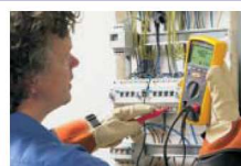
Test izolace na deskovém rozvaděči
